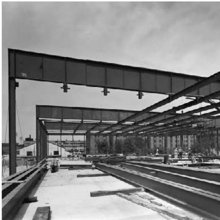
1-Crown Hall, un type de bâtiment surélevé ; 2-La construction en portique permettant le plan libre
