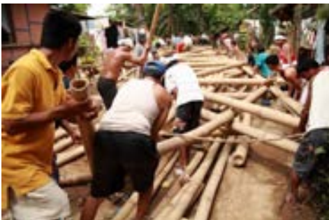
La construction en bambou : un savoir-faire ancestral en Asie du sud-est.
