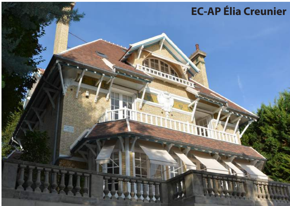
Restauration et réaménagement d'une « Villa affolante » à Saint Cloud
