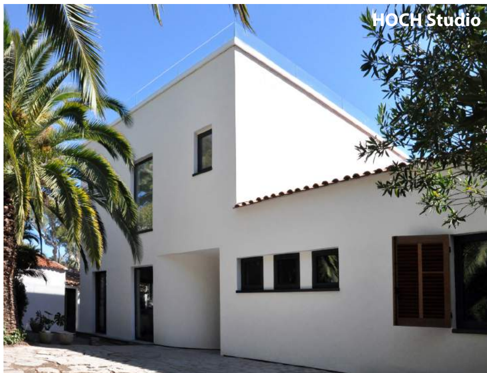
Surélévation et restructuration d'une maison, Saint Raphaël, 2018
