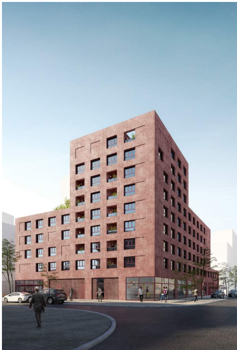
46 logements à Bobigny
