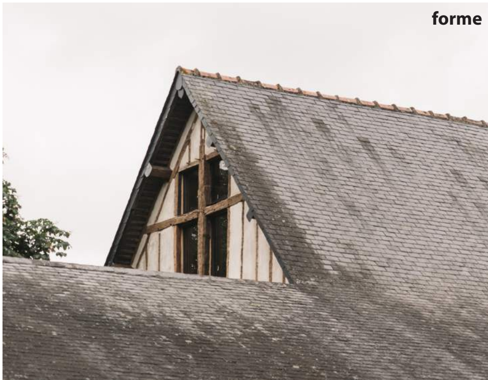
Réhabilitation d'un comble en salle de réception - 2017
