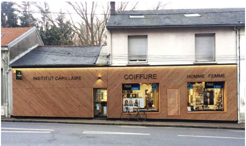
Restructuration d'une façade à Nantes
