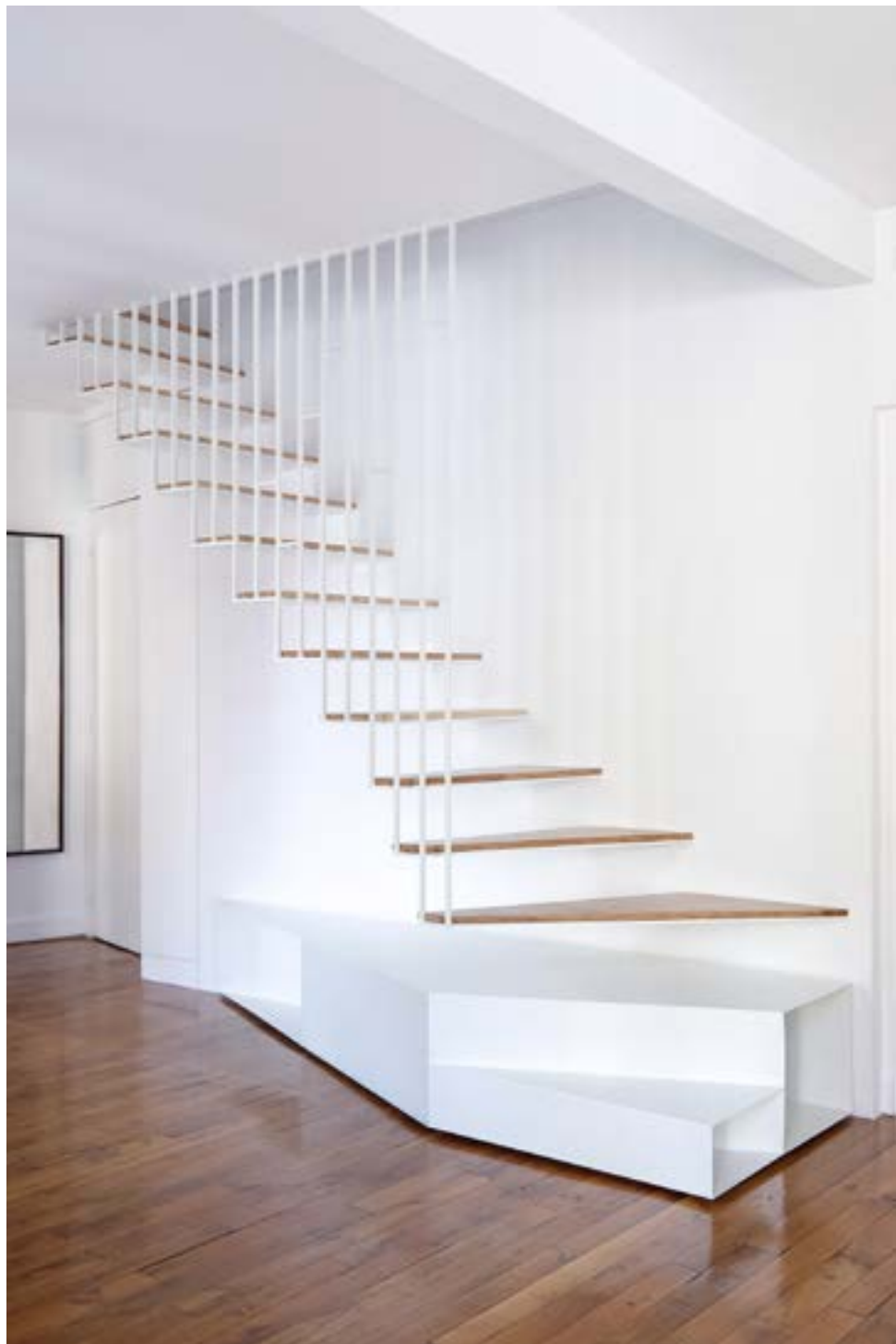
Création d'un escalier pour liaison de deux appartements - acier thermolaqué et chêne naturel - Malakoff (92) - 2018
