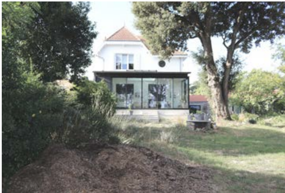
Villa Quirouard - Extension et rénovation d'une maison - La Plaine sur Mer - 2019
