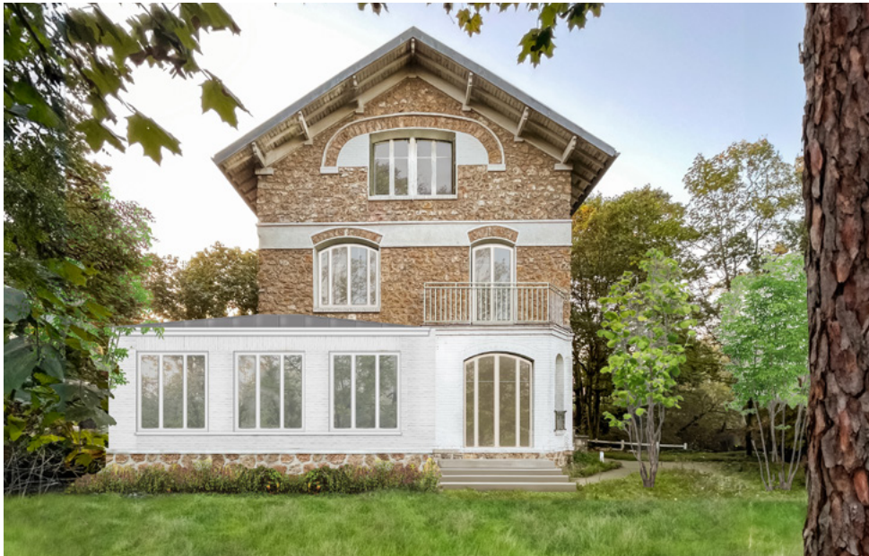
extension d'une maison individuelle - Maisons-Laffite (78) - 2024
