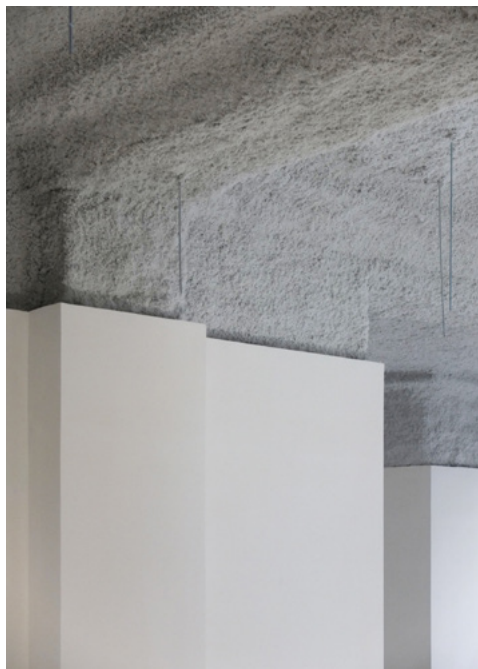
Bureaux rue de la Bienfaisance - Paris (75) - 2024
