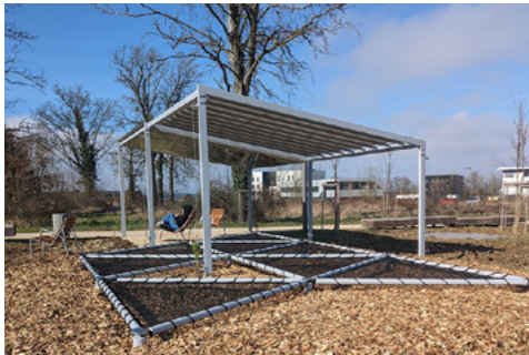
ZAC Pôle santé innovation de Mercy (en association avec EXP architectes) - Metz Métropole (57) - 2023
