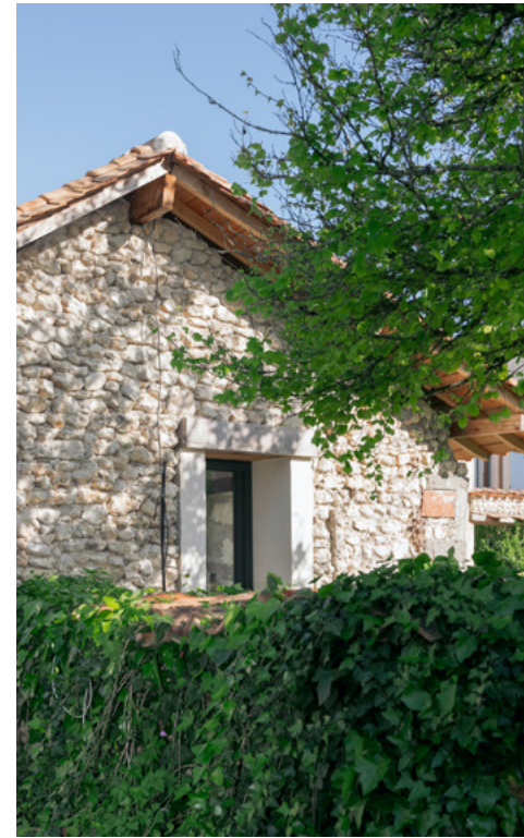
Rénovation d'une grange - Ribérac (24) - 2023
