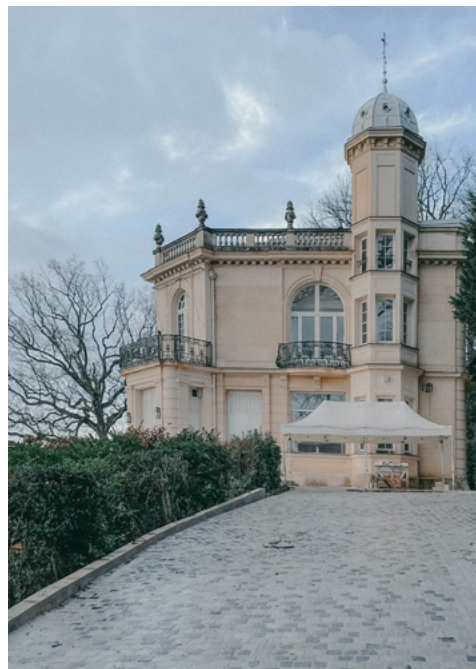
Réhabilitation d'un patrimoine inscrit- Saint-Cloud (92)
