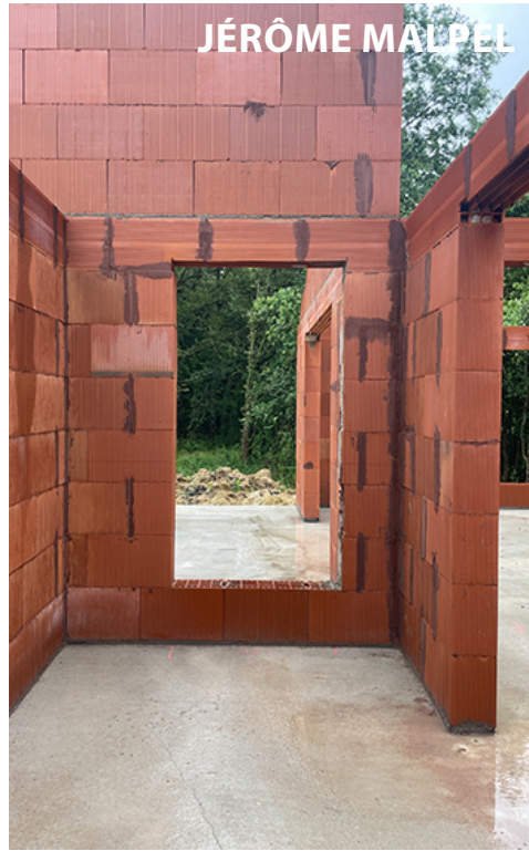
construction d'une maison individuelle - Chevillon sur Huillard (45) - en cours
