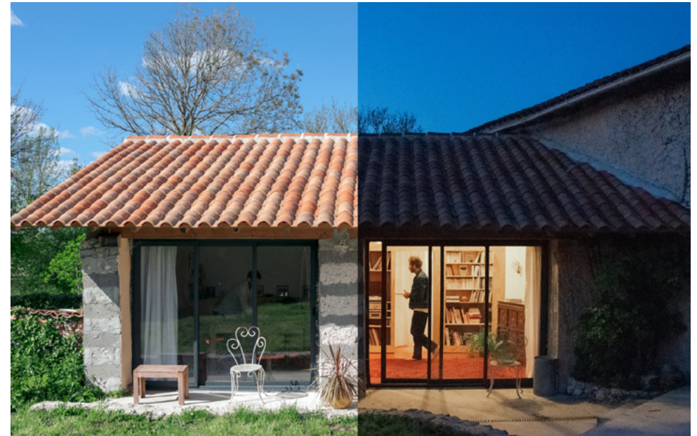
Rénovation d'une grange - Ribérac (24) - 2023
