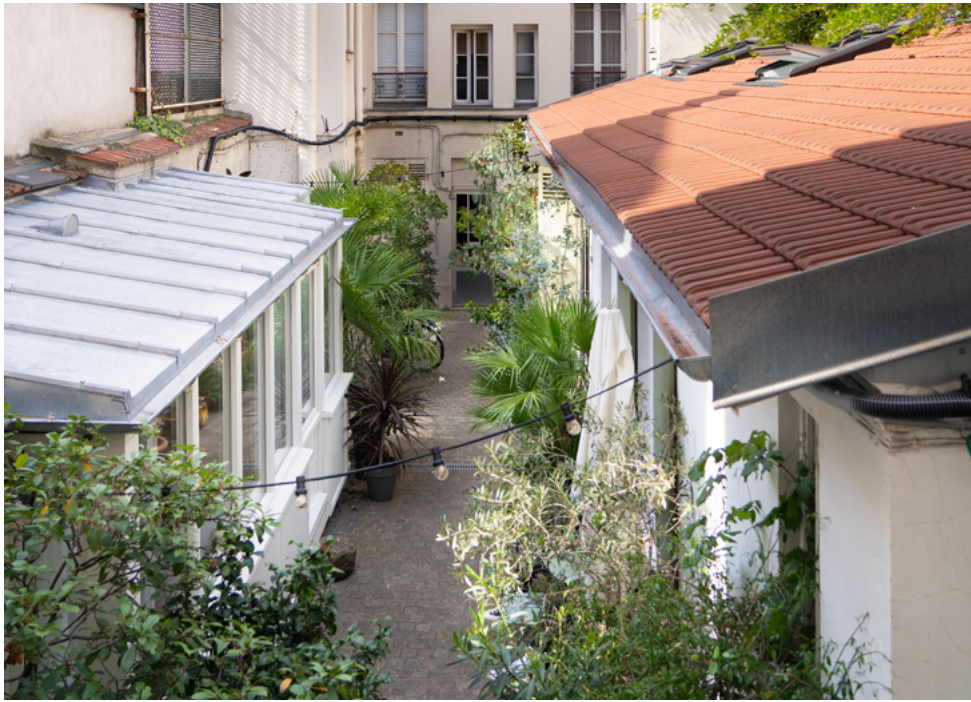
Rénovation d'une maison de ville et construction d'un espace pour artiste - Paris (75) - 2023
