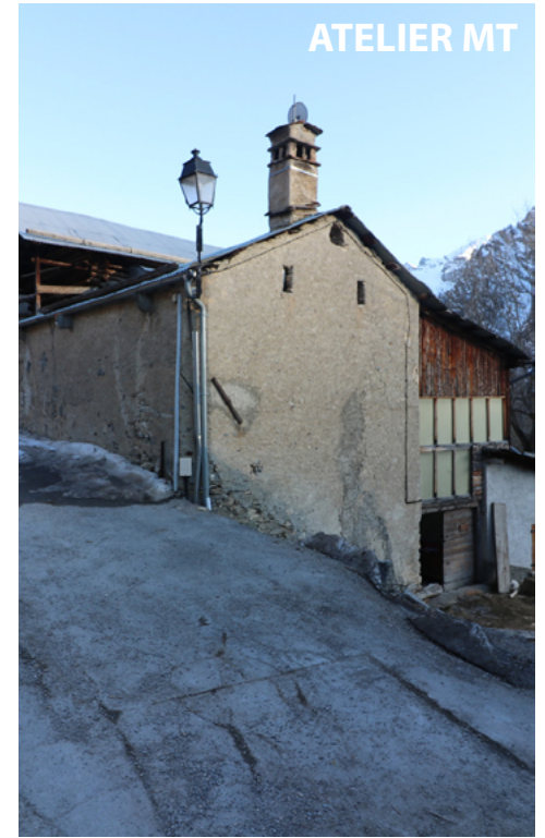
Réhabilitation d'un corps de ferme - Saint-Véran (05) - 2024
