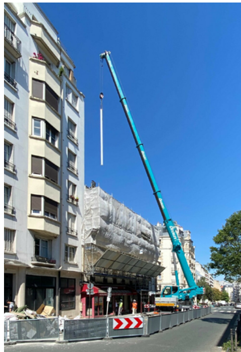
Surélévation d'un immeuble (avec Concorde) - Paris (75)
