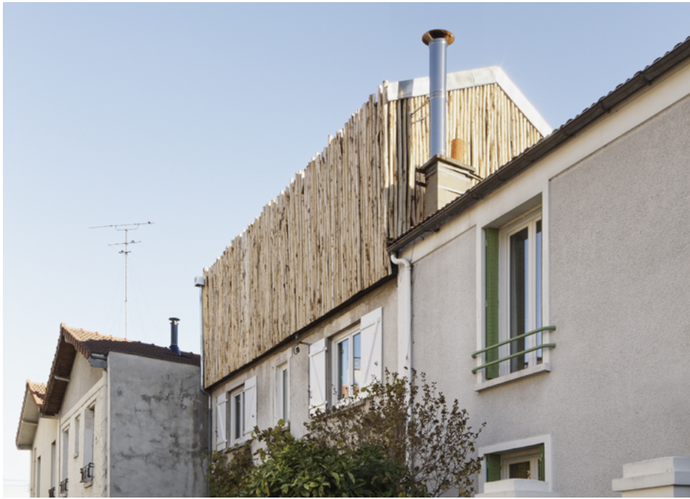
Surélévation d'une maison en ossature bois - Malakoff (92) - 2017
