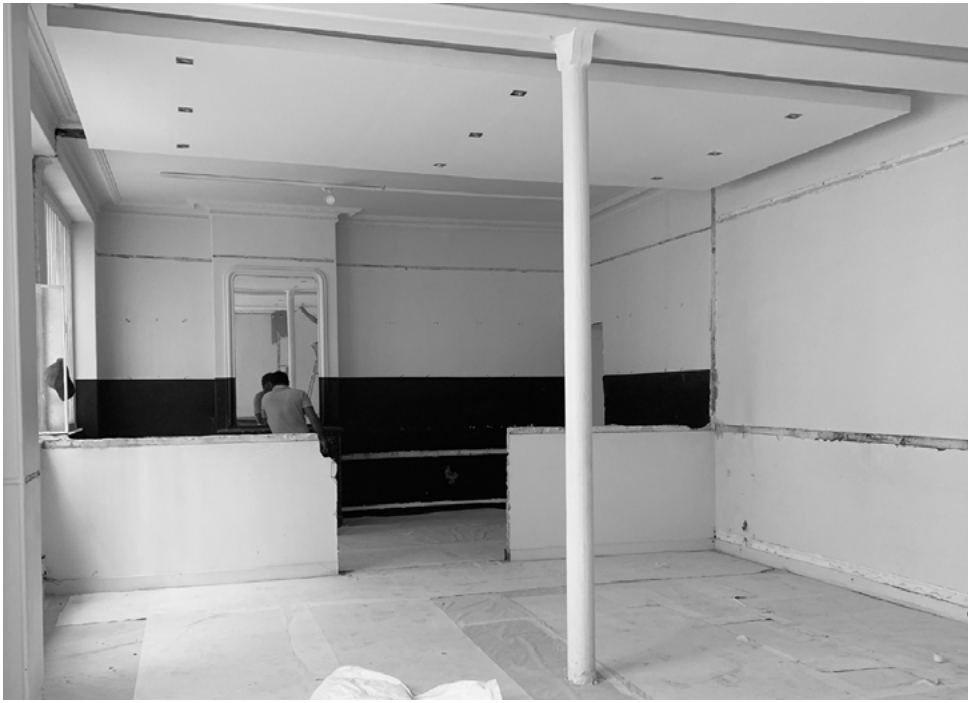
Aménagement d'un loft de 65 m 2 - Paris (75012) - 2022-23
